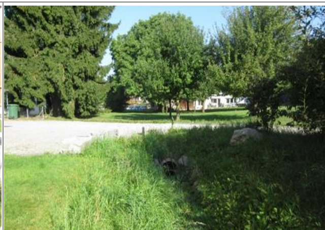
Einlauf in bestehende Eindolung
